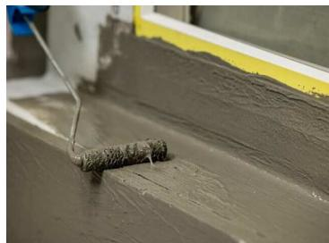
Kelleraußenwände sowie Fundamente lassen sich mit Aqua Blocker schnell, dauerhaft und sicher vor Feuchtigkeit schützen. Nach Durchtrocknung wasserundurchlässig, rissüberbrückend und beständig gegen natürliche betonaggressive Grundwässer.
